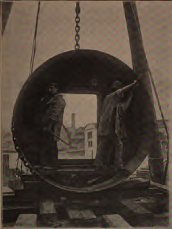
Fig. 324. — Vue de l'arrière du bouclier.
